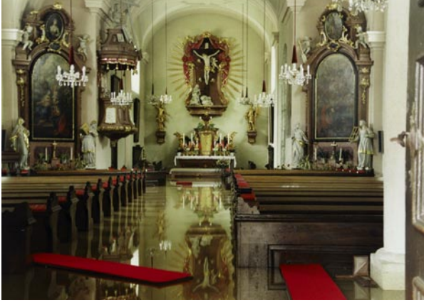
Überflutungen in der Kirche von Hadersdorf, August 2002
