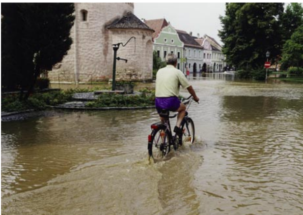
Historisch wertvolle Bausub- stanz in Hadersdorf steht tagelang unter Wasser, August 2002
